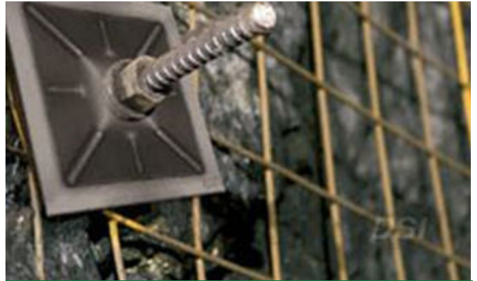
• Anclaje en roca
