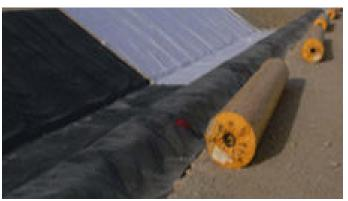
Presas, diques y canales: Los geotextiles no tejidos proporcionan filtración y separación entre el material sumergido y el material de protección.
